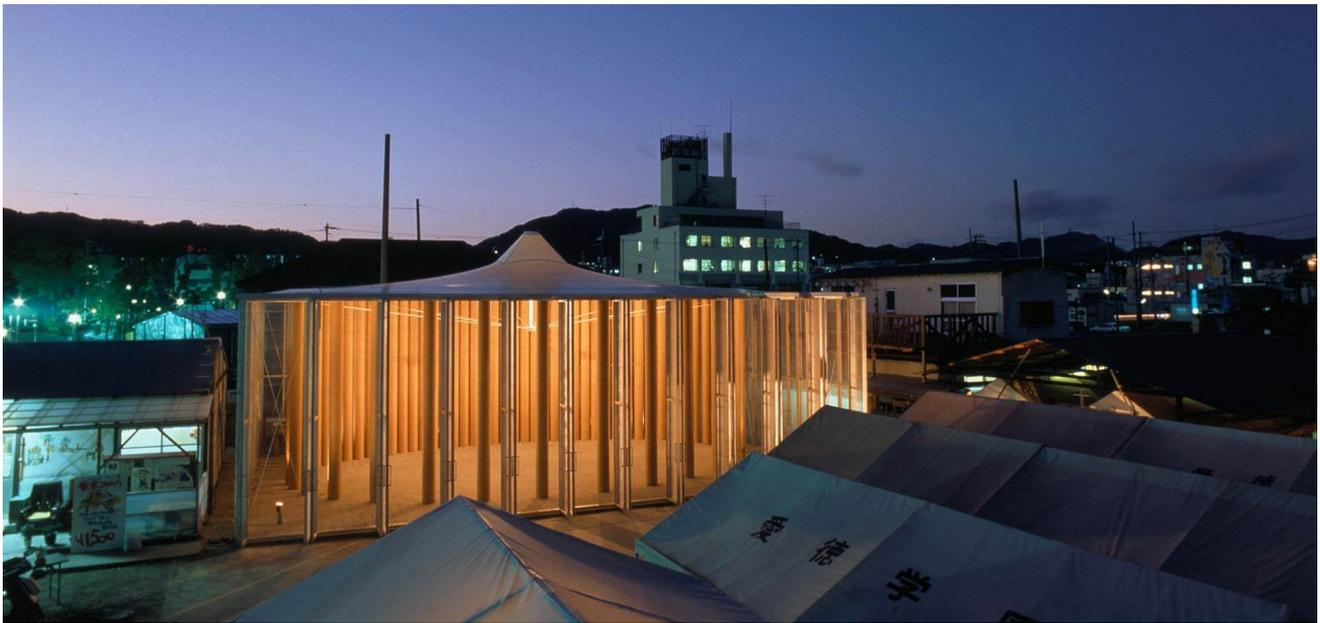
阪神大震災により焼失した教会のために建てられた紙の建築によるコミュニティーホール。建材は各企業からの寄付を受け、160人以上のボランティアの手により5週間で完成した。建設10年を迎えた紙の教会は、神戸と同じように震災の被害を受けた台湾に移築され、地域のコミュニティーセンターとして新たに活用されている。
