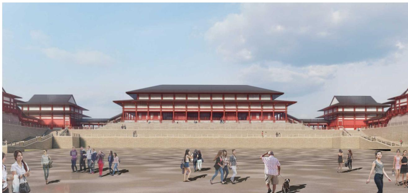
基壇の上に軽い紙管を用いたパビリオンを設けることで、基壇への雨水の浸入を防止し基壇を風化から保護する。外部の柱には伝統的な「朱漆」を使うことで、耐久性を確保しながら唐代の大明宮を復元する。
