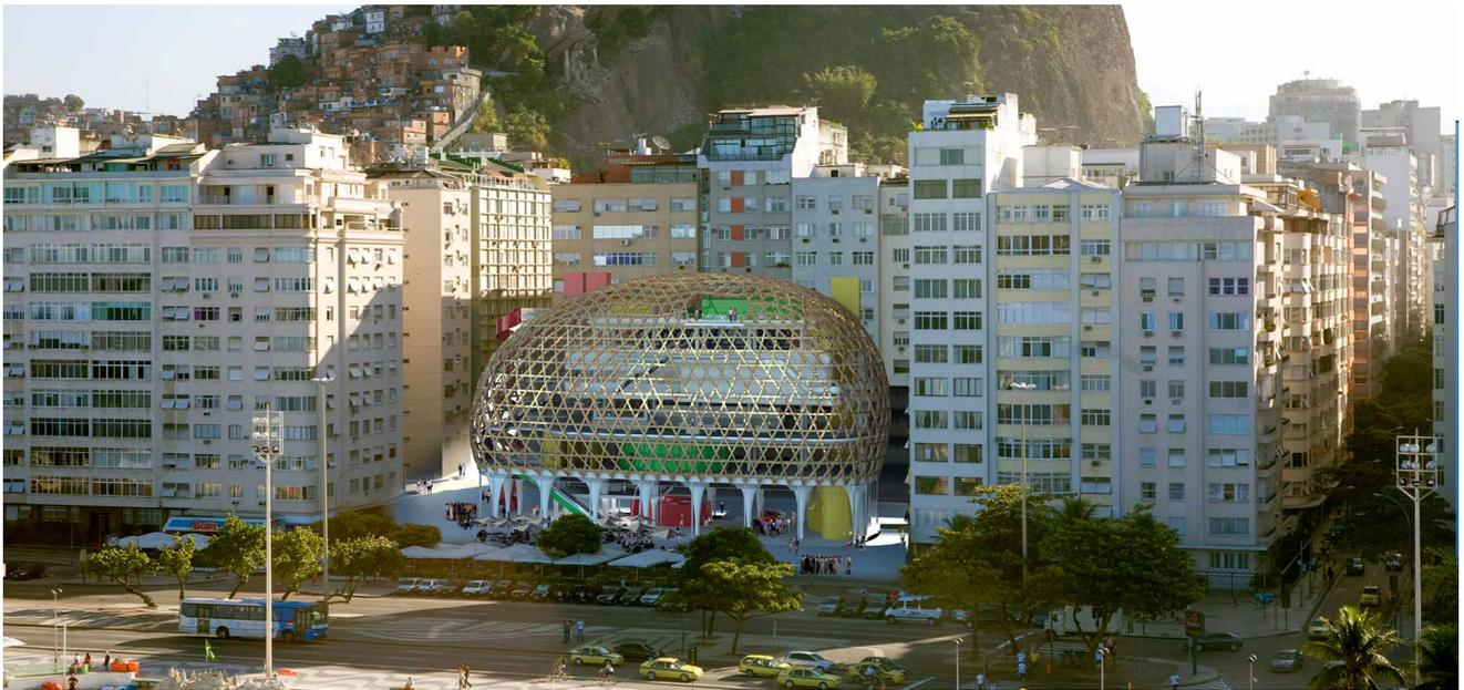
コパカバーナビーチ沿いの街は、リオデジャネイロ市と自然とを分ける巨大な壁となっている。この壁を取り払うために、女性的な曲線で、柔らかい丸みを帯びた形状のミュージアムを建てるという計画である。ミュージアムの外壁は二重のガラスと木製格子シェル構造で構成されている。木構造にすることで、工事期間中に排出するCO2の量は、鉄骨構造に比べて四分の一の量で済む。1階は、通りのあるロビーと企画展示スペースに接続することができるように、全開可能なガラスシャッターとしている。
