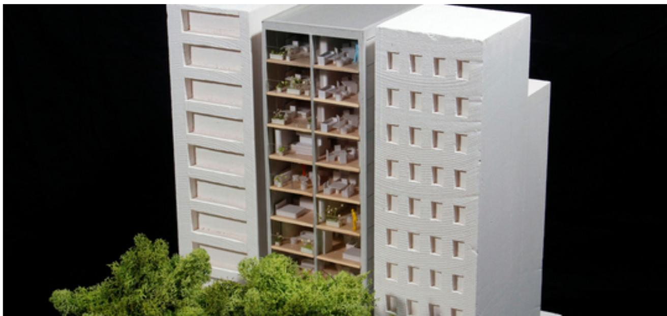
高さ30mの10階建ての都心に建つ集合住宅である。敷地が面する2つの道路に向けて開放性を確保するため、隣地側に2枚のRC壁、そして中央に階段室を設け、その間に2時間耐火を持たせた木の床版をスパンさせている。また、水廻りはポンプアップ式の水廻りユニットを開発することで、構造床を下げることなく、小さな階高で最大限の天井高を確保している。
