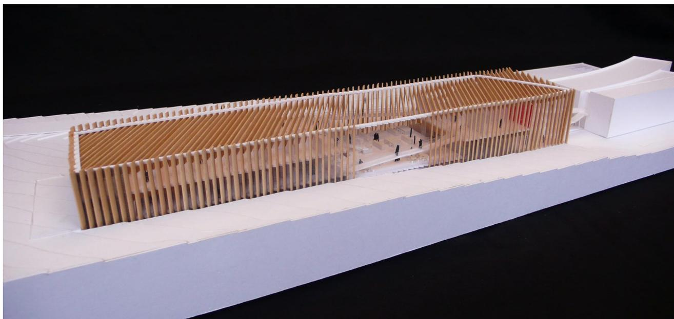
ベルギーのLeuvenに計画されたGCEUROPE本社の事務所棟。一つ屋根の下に全ての事務部門を集約したいとの要望に対して、長さ88m、奥行18m、高さ10mの箱状の木造空間を設け、中央の吹抜を中心にスキップフロア状にオフィススペースを配置した。
