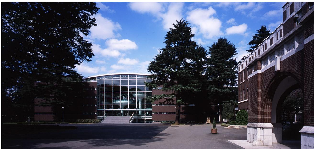
全体を3つのボリュームに分け、両サイドにレンガの外壁の書架棟を配し、2つの書庫棟に大屋根を架けるという単純な操作で、中央に30m角の開放的なアトリウムを作り出している。屋根は鉄と集成材を組み合わせたハイブリット構造で、木の構造がアトリウムを柔らかく包み込む。内部は図書館の利用目的ごとに音のレベルに沿ったゾーニングを行い、研究や集中的学習のレベルには「個室閲覧室」、積極的議論を伴う学習のレベルには「グループ閲覧室」、そして試験の情報交換のように通常の会話を伴うレベルには「閲覧スペース」という3つの音のレベルを設定し、それらを入口から奥に行くにしたがい静かな空間になるように配列し、様々な学習に対応できる「喋れる図書館」を実現した。
