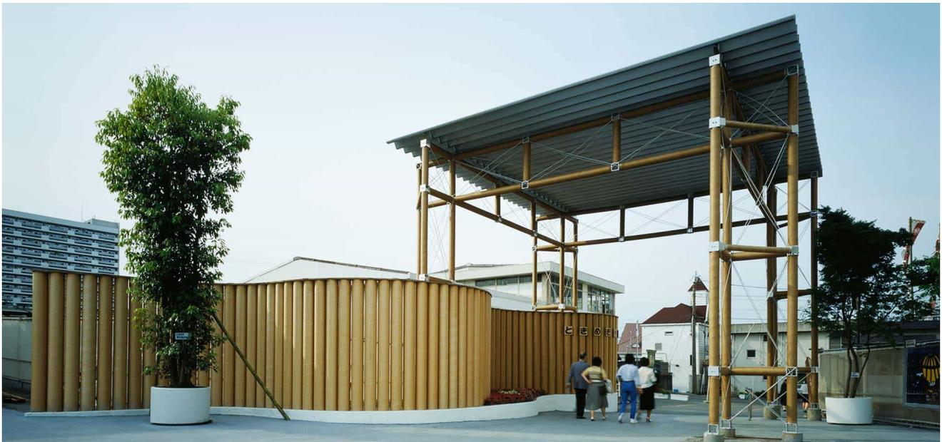
紙管のトラスによる小田原パビリオンのゲートである。ゲートは建築確認申請が不要なため、認定なしに純粋な紙管の構造となっている。柱梁のフィーレンディール門型架構とし、鉄筋のブレースを併用している。ジョイントはスチールアンクルを用い、紙管の中空部に入れた鉄筋でポストテンションを入れ、一体化している。
