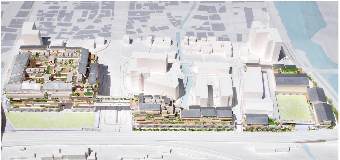
郊外から京都駅近くへのキャンパスの移転に際し、下層階はピロティとしまちに開かれた交流と情報発信の場としている。音楽学部と美術学部との積極的な交流を生み出すため、中層階を音楽学部、上層階を美術学部とし、双方の交流を促進させる断面計画としている。1.5間と3間のグリッドを重ねたタータングリッドで平面を構成するフレームシステムを導入し、大学の要望によって平面計画を柔軟に対応できるようにしている。
