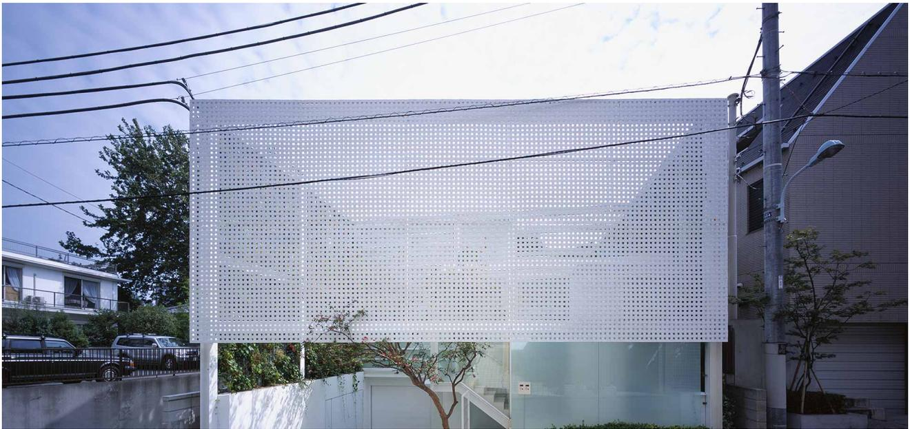
スタッキングシャッターを使った一連のプロジェクトのひとつである。プランは内部空間と外部空間をチェッカー状の配置にしたがってまとめている。ガラスにより視覚的に内部と外部をつなげているが、そのガラス面をスタッキングシャッターで構成することによりフィジカルにも内外の空間を連続させている。
