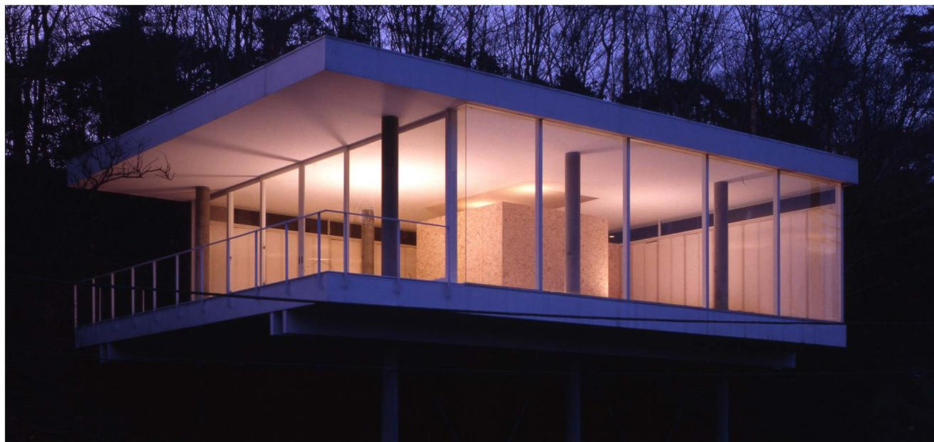
敷地は場所によっては45度以上にもなる急斜面であるが、特別基礎に予算をさく余裕がなくローコストを要求された。良好な周囲の景色とプライバシーを確保し、しかもそれをローコストで実現するため、杭として作られたPCパイルを独立基礎に差しこみ、それに床と屋根を支持させている。東南2面はガラスで眺望に対して開き、西北2面はポリカーボネートを2重に張り、間に発泡スチロールの粒を充填することで、断熱性の高い壁としている。
