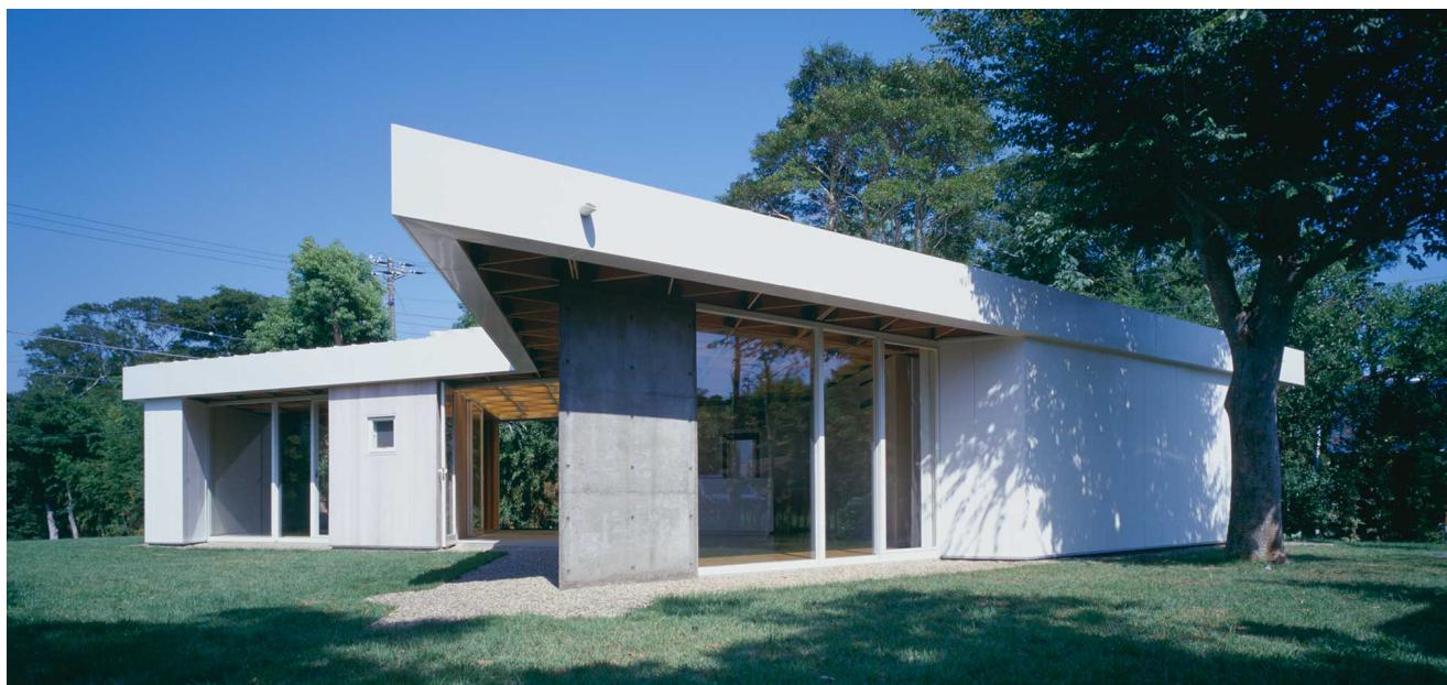
「ねむの木美術館」では屋根、「ハノーバー国際博覧会日本館」では妻面で使用した三角格子構造のために開発したアルミのジョイントを利用し、ここでは紙のハニカム材の代わりに構造用合板を面材として利用している。この三角格子屋根は構造家具とサッシュのマリオンにより支持させ、屋根と下部構造体を視覚的にも施工的にも完全にアーティキュレートしている。
