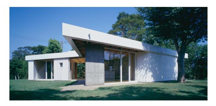
「ねむの木美術館」では屋根、「ハノーバー国際博覧会日本館」では妻面で使用した三角格子構造のために開発したアルミのジョイントを利用し、ここでは紙のハニカム材の代わりに構造用合板を面材として利用している。この三角格子屋根は構造家具とサッシュのマリオンにより支持させ、屋根と下部構造体を視覚的にも施工的にも完全にアーティキュレートしている。
