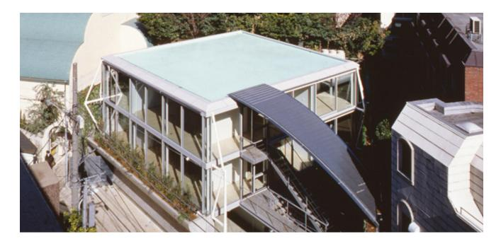
建物の周囲のアイビーの壁が外構的スクリーンとしてだけでなく、本体の主体構造も担っており、このアイビーという植物自体の何か別の構造体に頼らないと自立できないという特色がこの建築の特性を表している。単純な正方形平面の4隅とテラス部分を周囲のアイビー・スクリーンのフレームと結び、水平力を負担させている。これにより正方形平面に9スクエア・グリッド状に配置した丸柱は水平力を負担せず、柱径が最小限となり、将来の変更に対するフレキシビリティーを確保している。
