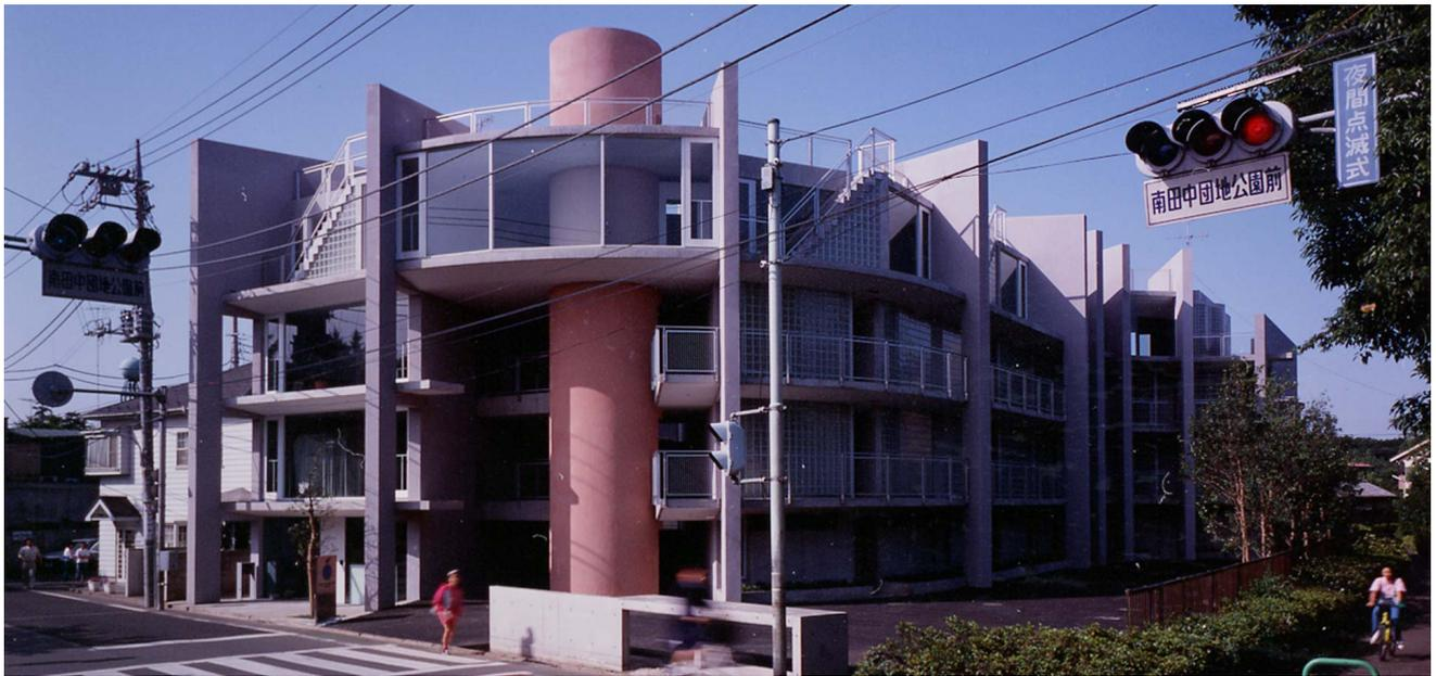
これまでの住宅と同様、開放性をテーマとした集合住宅である。通常壁式構造では閉鎖的な空間になりやすいが、9枚のコンクリートの壁をS字型にドミノゲームのように配置し、2枚の壁に挟まれた個々のユニットのエッジはすべて開口部としている。個々のユニットでは1方向の壁しかないが、それらをS字型に配置し、それらをスラブで連続させることで水平力を伝え、全体としてはXY両軸方向の壁量を満足する配置となっている。
