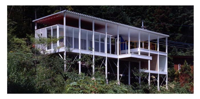
積雪量の多いこの地域において、架構を大きくせずにこの積雪に備えるために、屋根と天井を切り離すダブルルーフを考案している。応力上積雪荷重を受けられる最小限のサイズの折板屋根が全体を覆い、それとは別に天井の架構が独立してある。つまり天井は屋根から吊られていないので、屋根のたわみが規定を超えても影響がなく、積載荷重がほぼゼロの屋根となっている。
