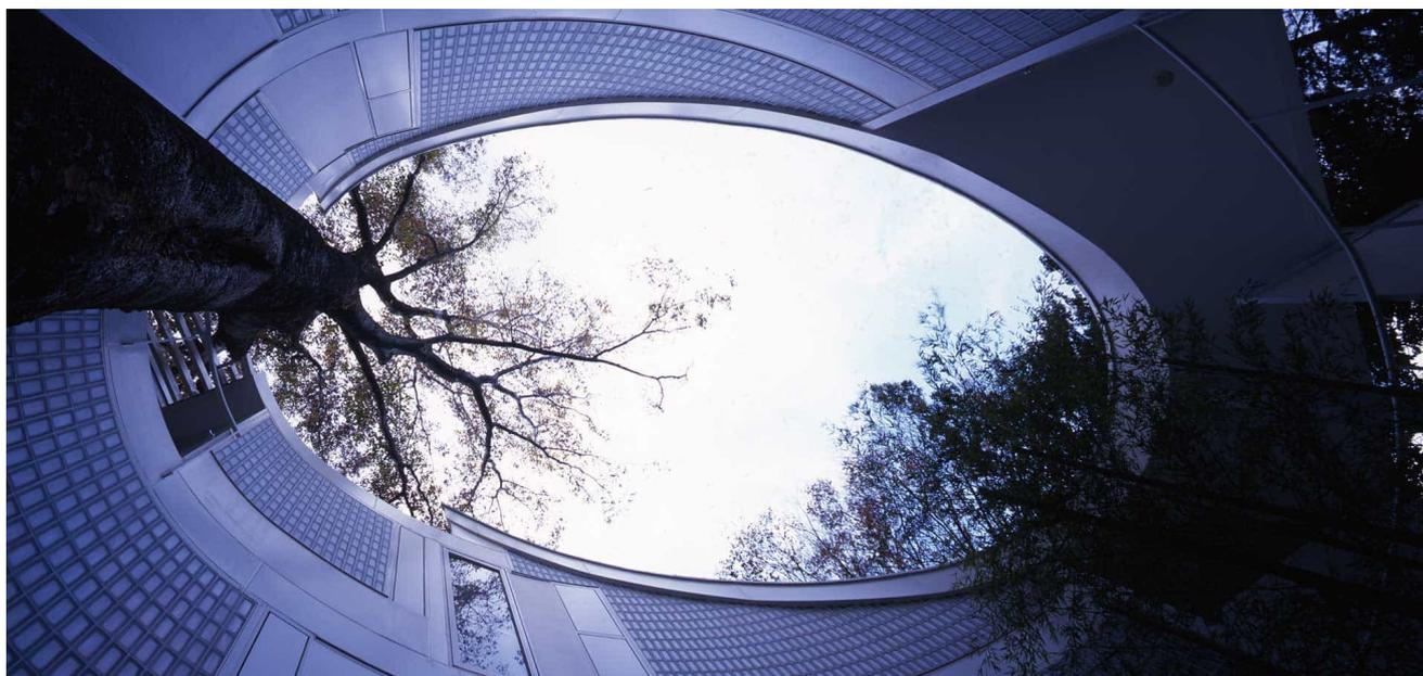
1階から3階で1住戸となる長屋形式の集合住宅である。既存の大木を1本も切らないという条件のなか、それらを守るために梁や地中梁を抜いても構造が安定するジオメトリとして、1辺4mの正三角形のグリッドを見つけ出した。1階のピロティーでは、森の中を歩く感覚を保存するため天井高を3 mとし、最小限に留めた個室は鏡とミラーガラスにより存在感をなくし森の木を増幅している。
