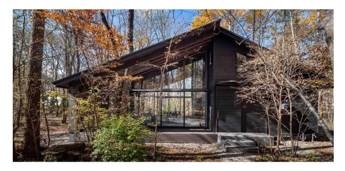
八ヶ岳山麓にある既存の別荘へ新たにリビングルームを増築する。片流れ屋根を持つ既存建物の平側へ同じ勾配の登り梁を架け、切妻屋根とし、既存との調和を取っている。増築部の本棚は、登り梁を受ける構造体であり、本棚と背板で耐力壁を構成している。閉鎖的な既存部とは対照的に増築部は周囲の自然を望めるよう全面開口可能な開放的な空間とした。
