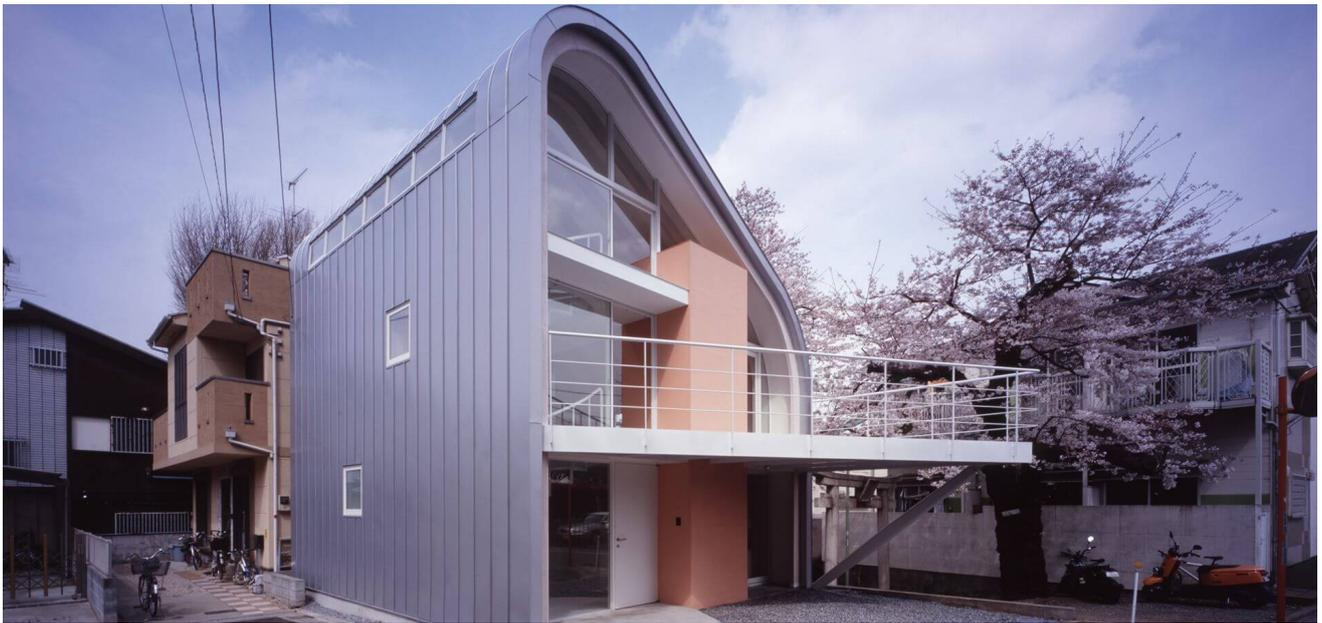
緑豊かな公園や、隣接する神社の桜の大木を臨むことのできる立地条件に呼応し、道路斜線制限からくる、ゆるやかな曲線を描く集成材が、柱・梁となって主要構造を担い、開放的な空間を演出している。設計においては、特に螺旋階段と、それに付随する落下防止の可動ドア、および、天板が吹き抜け空間の間仕切りともなる机のデザイン検討を繰り返した。空間を緩やかに仕切りながら、安全かつ容易に取り扱うことのできる可動ドア、机のシステムについては、材料、構法などあらゆる観点からのスタディを経て、実際の施工まで学生の手で行なった。
