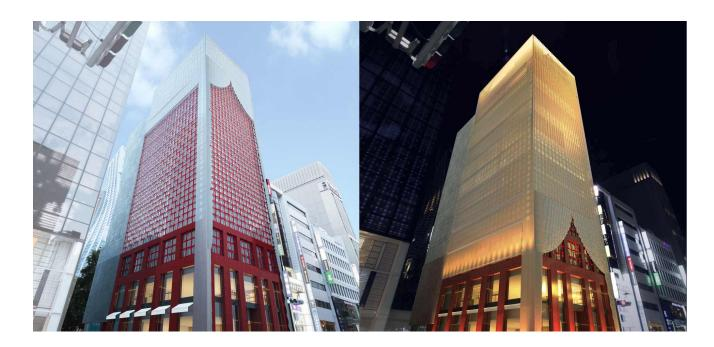
ファサードは、革新的な環境技術とブランドの伝統を表現した。基壇のブティックにはブランドの伝統的な店舗で使われているような赤い石を使い、古典的な秩序を表現している。基壇から上のオフィスのファサードは、日本の伝統的な網代細工のような窓枠で構成されている。中央通り面とマロニエ通り面の2つのガラスファサードは、編まれたステンレス鋼のリングで作られた可動式の遮光カーテンで覆い、太陽の動きに合わせて開閉する。
