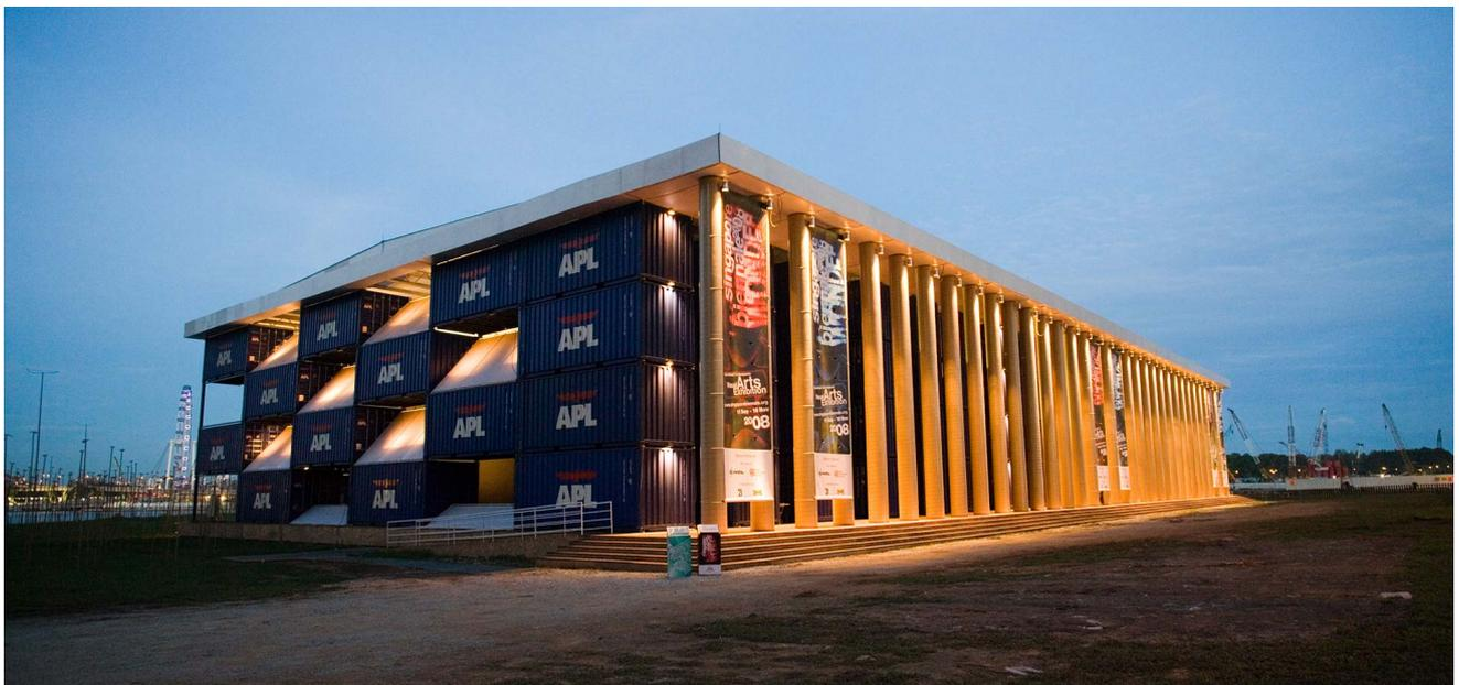
シンガポール・ビエンナーレ2006のための案内所、兼プレスセンターである。紙管による初めてのスペース・フレーム構造。ビエンナーレ終了後移設を想定して紙管、金属接合部、柱管、基礎の全てのディテールを決定した。
