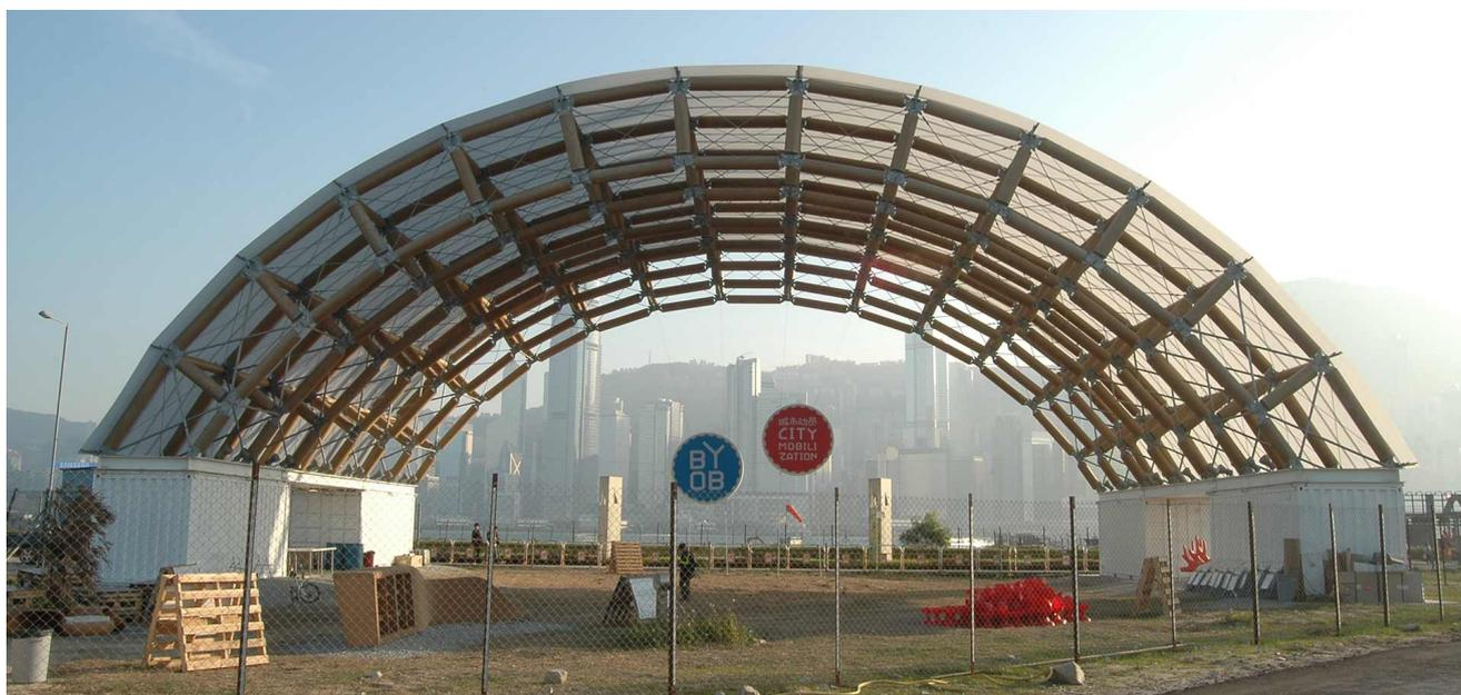
仮設パビリオンは、香港、西九龍文化地区の公園内で開催されていたビエンナーレのメインイベント会場に建てられた。スチールのジョイントと紙管トラスアーチで構成された18m長のボルト構造は、全長30mにおよぶ。メインアーチには直径336mmの紙管を、支柱には直径243mmの紙管を、そしてスチール棒はトラスの留め具に使った。基礎には4つの長さ20フィートの砂を詰めた海上輸送コンテナを利用し、屋根は半透明の波形ポリカーボネートパネルを使用した。
