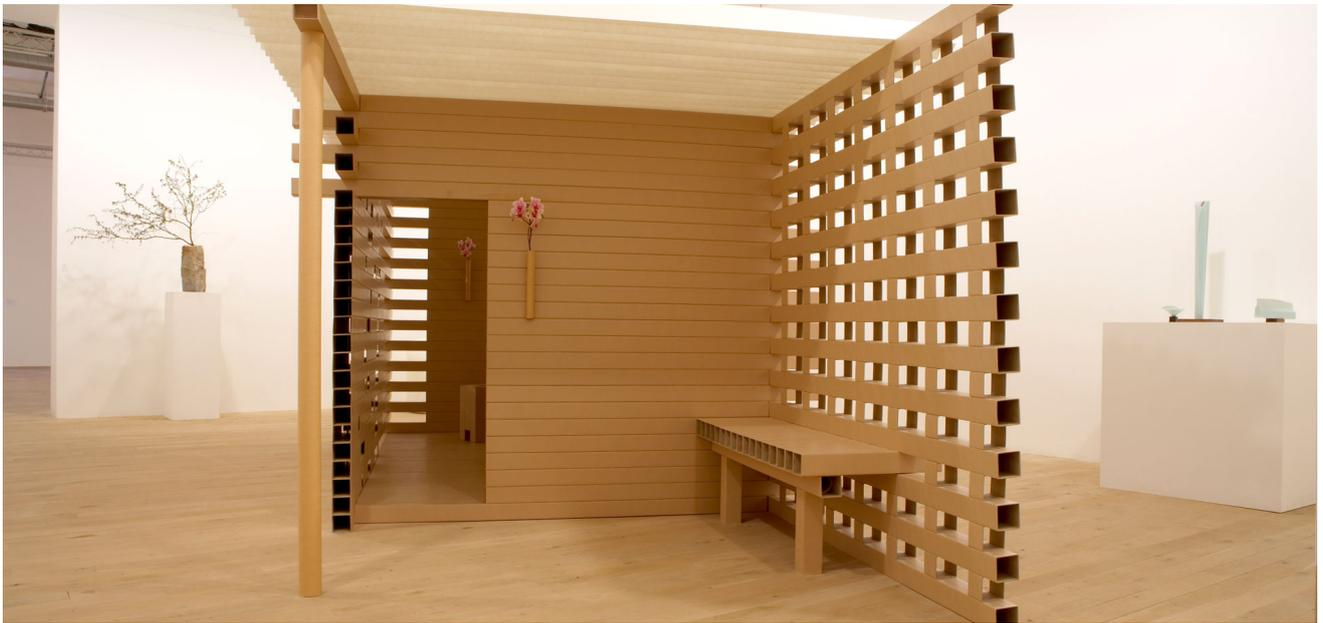
紙の茶室は正方形の紙管で作られている。壁は鉄棒によって接続され、屋根は一枚紙できている。八ニカム段ボールで作られたテーブルを除いて、床や家具もすべて同じ角紙管を使用。1種類の紙管で作ることで、組み立てと解体を非常に簡単にした。
