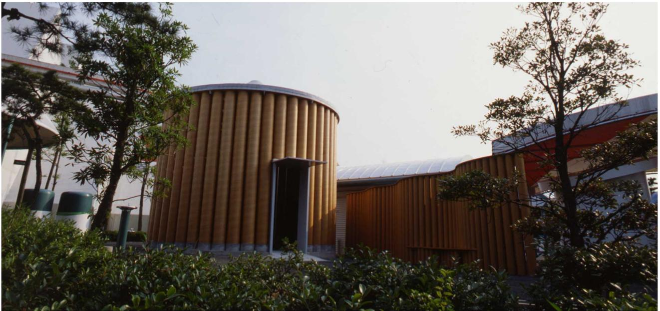
最近身近に体験することができなくなった水琴窟を博覧会会場の東屋として計画している。防水された紙管48本をPCベース上に差しこみ円形に並べ、上端をリングにより一体化している。紙管と紙管のすき間からは風が通り、何本もの光の帯が室内へと舞い込み、また夜には東屋自体が48本の光の帯を持つ照明器具と化す。
