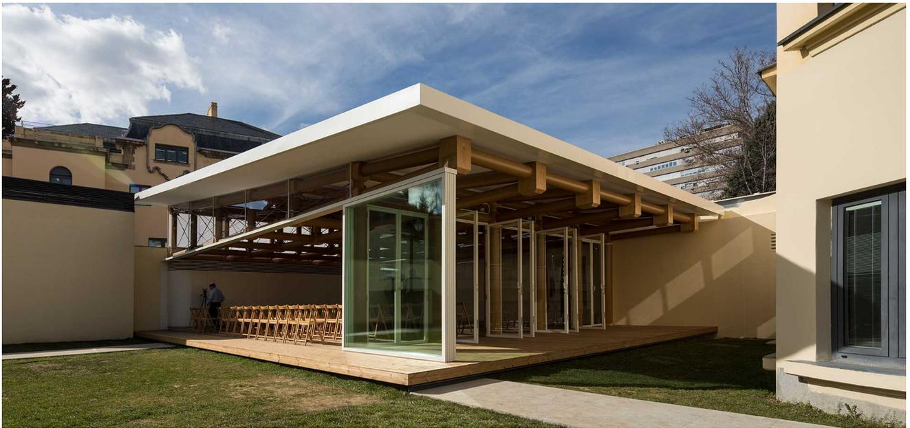
パビリオンは、L字型のコンクリート壁と6本の紙管の柱、そして紙管のトラス屋根で構成されている。再生紙で作られた紙管は、地元のピナ・デ・エプロで製作された。紙管のトラス屋根の組み立てには、建築学科の教育の一環として学生も参加し、コントラクターと共同で作りあげた。
