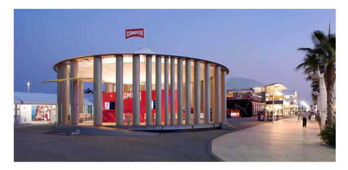
風通しの良いオープンなパビリオンは、紙管の柱を特徴とした円形構造である。紙管の柱は中が空洞になっていることで、 互いに内側に入れ子状にすることで、輸送時の容積と負荷を減らした。
