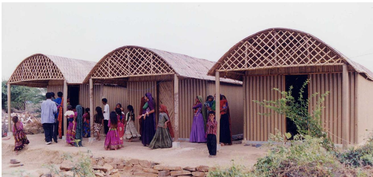
2001年にインド西部の町ブジを襲った大地震の被災者のために改良した紙のログハウス。建物の瓦礫を土台にして、その上に泥を固めて伝統的な土間床としている。屋根は竹のヴォールト小屋組に既製品で伝統的な籐の網代マットを2重にし、間にビニールシートをはさんで小屋組に固定している。半円径の妻面に籐の網代を使い、ここから自然換気が行われる。
