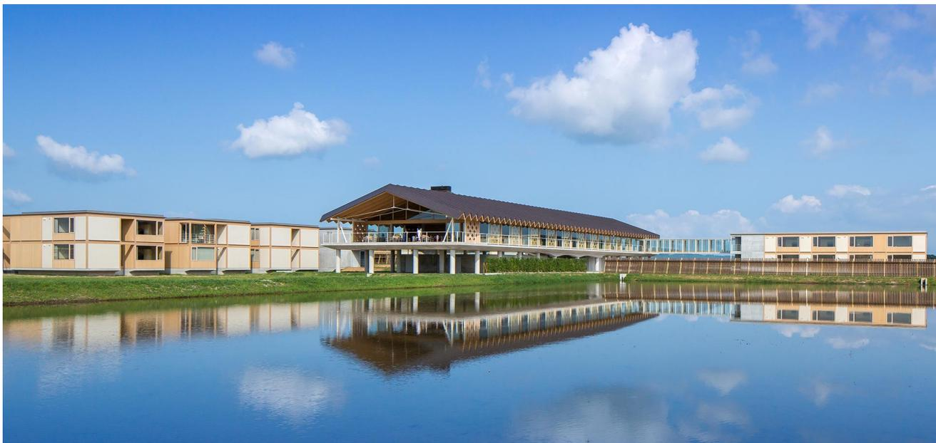
山形県鶴岡市に建設した約150室のホテル。庄内平野の美しい水田の風景を壊さず、水田を残したまま建築を配置させるため、ホテルのそれぞれの機能に合わせた3つの別々のシステムの木造建築をいくつか散ばせて配置した。150室の客室は水田の中にスケールが巨大すぎないように2階建の3つのクラスターに分けて配置した。3つの客室棟の中央の共用棟は、軽やかに水田に浮かんでいるように一階部はRC造のピロティとし、その上にRC造のコアと鉄骨の柱とLVLの耐力壁を配置し、その上に集成材の折板屋根を載せた。大浴場の屋根は、ポンピドーセンター・メスの屋根と同じ、各ジョイントに2方向の材しか交わらないよう六角形と三角形のジオメトリーを、上下弦材が木片で構成されたフィーレンディールトラス状の竹を編んだ帽子のような構造のドームとした。
