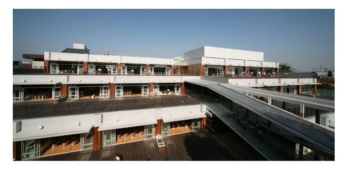
成蹊大学キャンパス内の小学校。各教室は等しく南面採光となるよう教室群を階段状にセットバックさせている。これにより各教室は内部と外部がひと続きとなった広いテラスを持つ。また北側にはホールなどのパブリックスペースを吹抜けに面して配置し、北側ながらも安定した採光を得られるようにしている。
