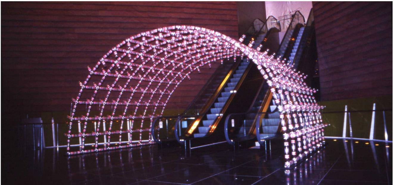
六本木ヒルズ、森美術館での展覧会のために、エントランスゲートとしてペットボトルを構造としたアーチを製作した。ペットボトルの下部同士をテープで固定することによりそれらはひとつの部材となり、さらにキャップ部分をアクリル製のジョイントでつなぐことで、アーチ構造を成立させている。外部からの荷重に耐えられないため、屋内に限定され実現した。
