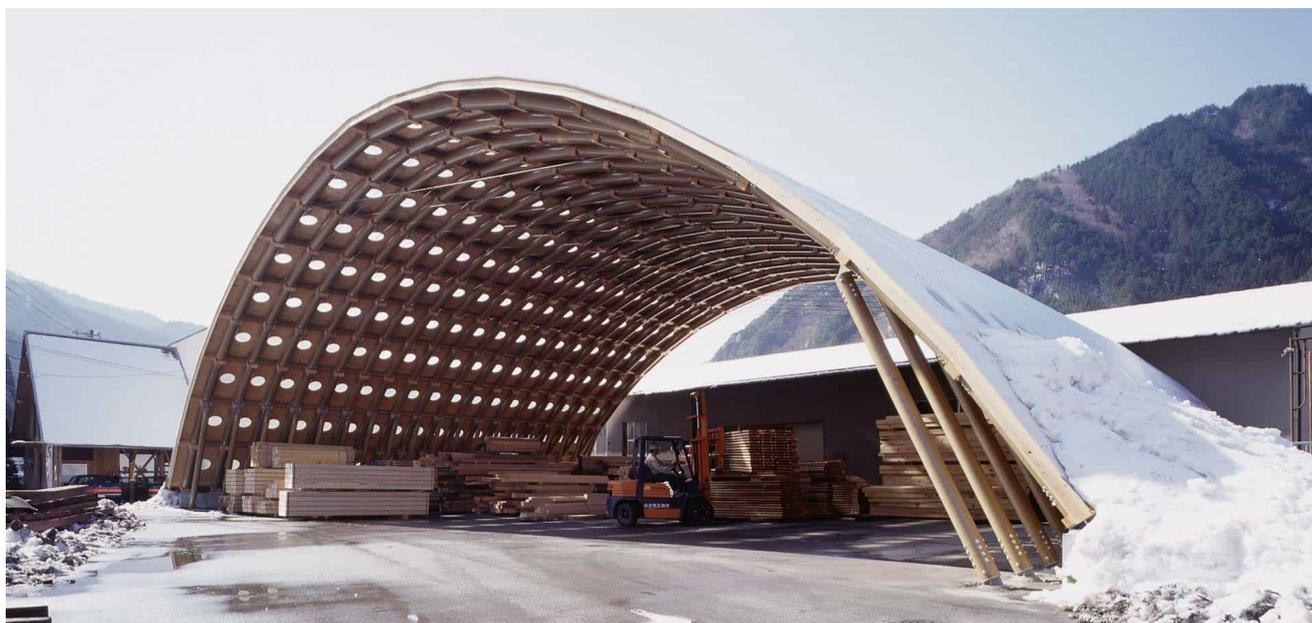
木造住宅専門の工務店のために恒久建築として設計した紙のドームである。紙管を曲げることはできないので、アーチを直線に分割し、集成材のジョイントで接合し構成している。水平剛性は筋交いの代わりに屋根の下地を兼ねた構造用合板で負担している。この合板には、構造に影響しない範囲で円形の穴を空け、屋根のポリカーボネート波板を通して自然光が入るようにしている。
