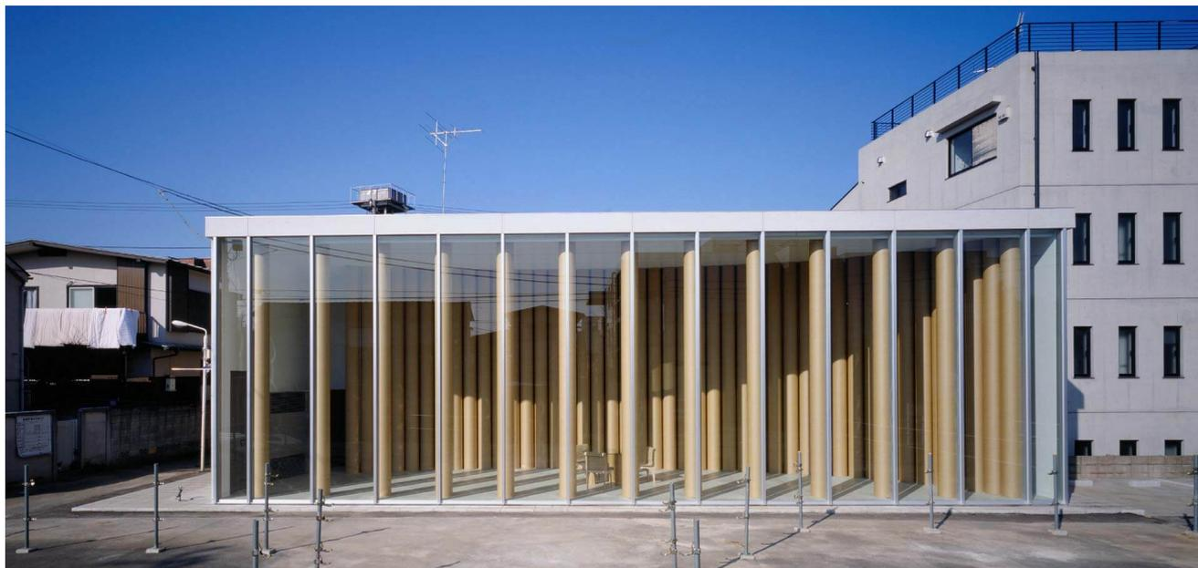
紙の建築によるギャラリーである。鉛直荷重はすべて紙管の柱に支持させるが、水平力は耐火構造の外壁に負担させることにより支持し、紙管と床のジョイントはずれ止めだけの簡易なものとしている。細長い矩形の空間に配した紙管の列柱によって床にできるストライプ状の影は、時間を追って生き生きとした表情をつくり出す。
