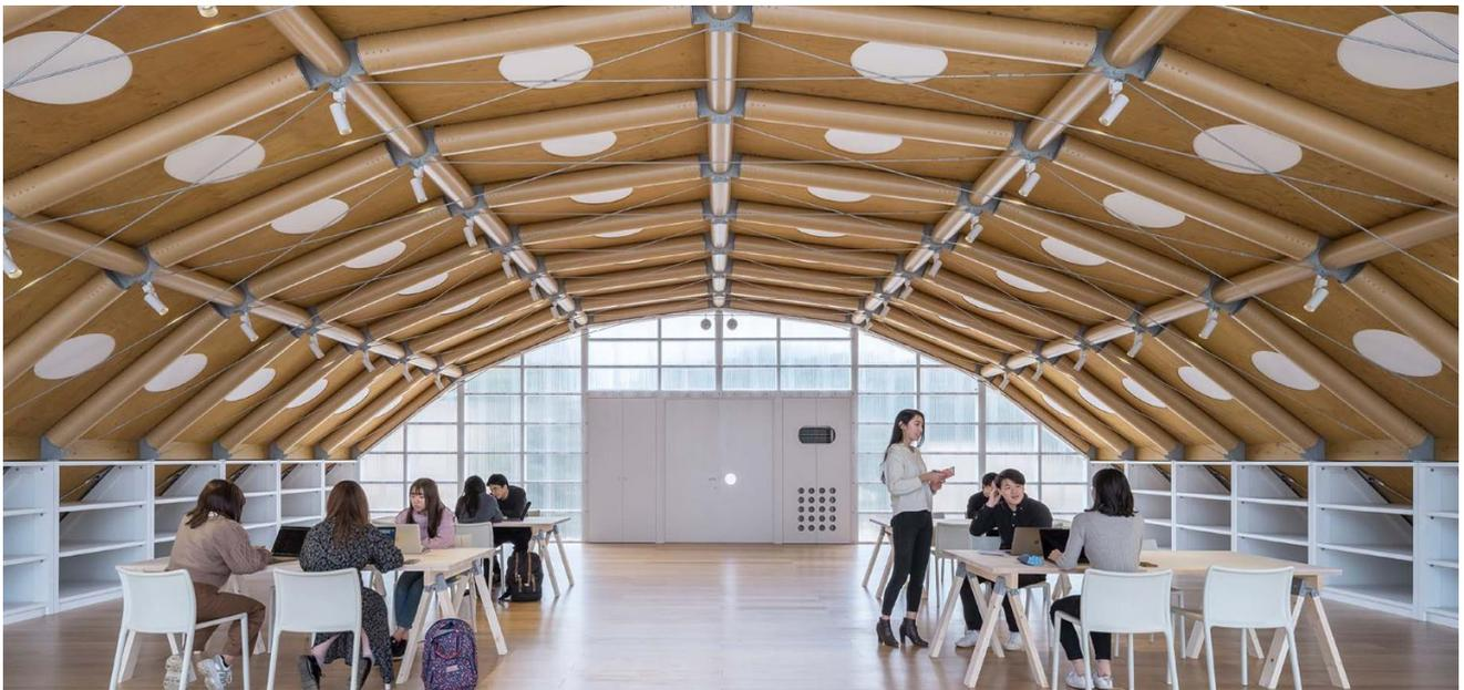
慶応大学のSBCプロジェクト（Student-BuildCampus）の一環として学生が施工することが求められていたことから、心材に八ニカムボードを利用したPHPパネルを利用することにより、学生でも持ち運びできる重量に抑えたフレームを利用した。PHPパネルを中心のリングに集め、直径14mの無柱空間を構成している。
