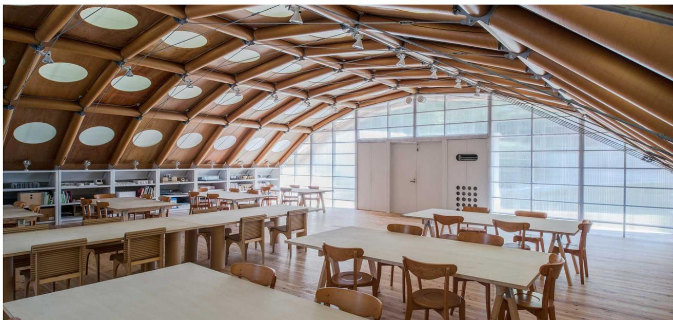
京都造形芸術大学にて、再び学生自身による仮設アトリエを「紙の構造」で建設した。移設可能なように紙管両端のスチールジョイントをポストテンションを入れたスチールロッドで固定した。アーチの面剛性は2.2m×1.2mの紙管グリッドに構造用合板を固定し、その上に断熱用発砲スチロールを敷き膜で防水した。構造用合板には丸い穴をあけて、発砲スチロールを通して自然光を室内に入れた。その穴を利用して、施工時にはアーチ下の足場から胴体を出して、屋根の上に登らなくても合板の固定作業ができるようになった。学生に建設作業を任せるためには、安全な施工方法、重機を使わない建て方と部材寸法、特殊技術が不要のディテールを考慮することがデザインのクライテリアになる。
