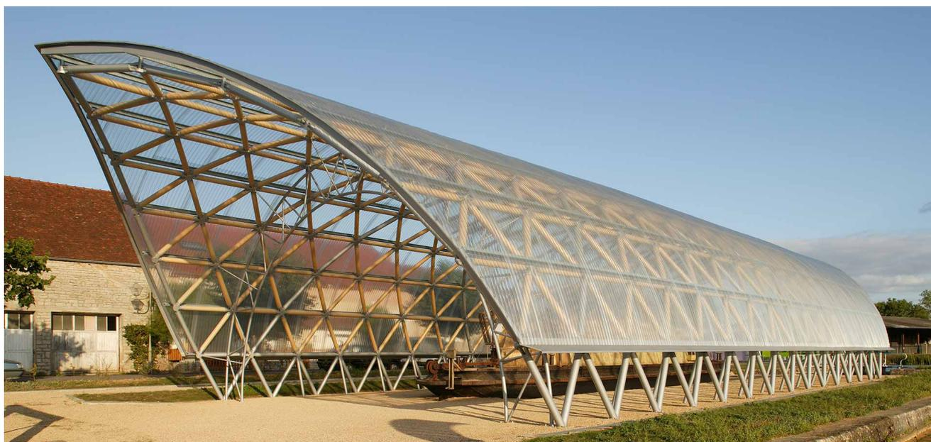
歴史的に重要な運河船を格納するためにつくられたボート・ハウス。紙管をつかった三角格子のグリッドシェルで構成され、外面をポリカーボネートで覆っている。「ハノーバー博覧会日本館」の架構で使用したものと同じ大きさの紙管を使い、同じ実験データでフランスの認定を受けられるよう、鋳型アルミニウム製のジョイントを開発した。
