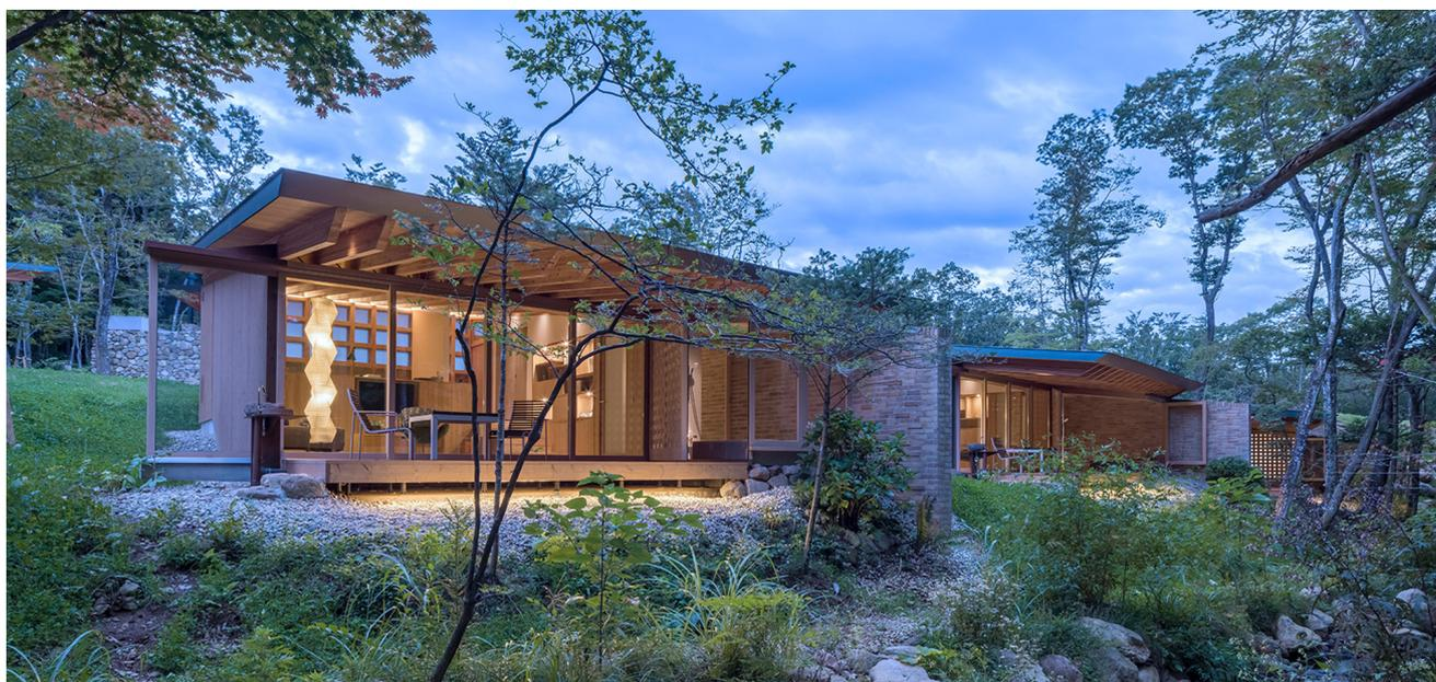
約16,000m<sup>2</sup>の広大な敷地に計画された分棟形式の宿泊施設である。敷地の両脇を流れる溪流を間近で楽しめるように、土地の形状を活かして、全棟木造60m<sup>2</sup>の14棟（計15室）のヴィラが配置されている。緩やかな傾斜の土地に沿うように、室内はスキップフロア形式になっており、大開口の4枚引戸を開けると、大きく外へ張り出した屋根の下に設けられた奥行き3mのテラスと室内が一体的に結ばれる構成になっている。幅5.4mの大開口部は、450mmピッチで並ぶ12m長の登り梁を束材として木製上下弦材で挟み、筋交いを入れてトラスを形成することにより大梁をなくすことで、屋内外の空間が途切れず連続している。浴室は2面を開けることで半屋外空間となる。外壁には敷地の造成中に出土した石が使われている。
