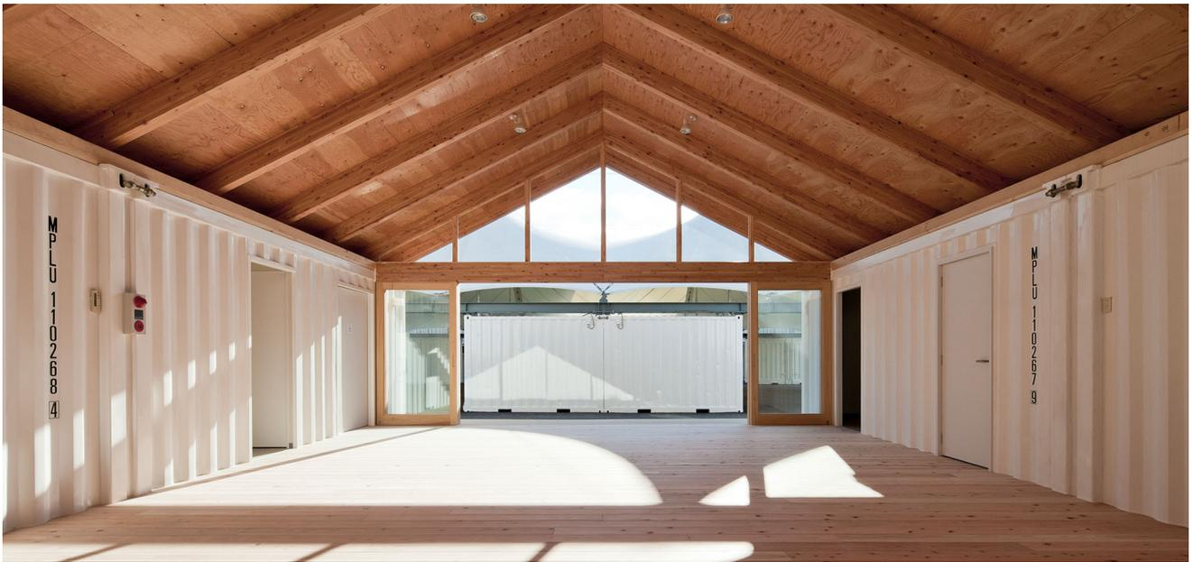
仮設住宅を多層にすることで広々とした棟間隔を取ることができたため、同じ敷地内に併設可能となった集会所の設計も同時に行った。住宅部分でも使用した20フィートコンテナを左右に2つずつ並べて設備や収納スペースを収め、コンテナとコンテナの間の空間には木造の屋根をかけて最大70人収容可能な集会スペースとした。天井材と床材には宮城県産の杉を現しで用いている。
