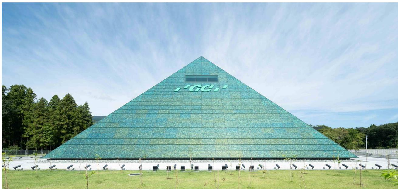
建設中の新東名高速道路に隣接する敷地に、会社創立100年を記念したシンボリックな工場の設計を依頼された。高速道路の車からも目立ち、歯科材料の原料を製造する工場らしく、更にトップには関係者が集う富士山の展望スペースを設けることが要求された。歯科材料の製造工程により下階の面積は大きく、展望スペースは小さく、また富士山とのコントラストとなるようにピラミッド形が導き出された。工場で使われる電力を最大限補う発電をするため、ピラミッド状であれば日射量の少ない北面も発電できることを確認し、全面をソーラーパネルで覆うこととした。
