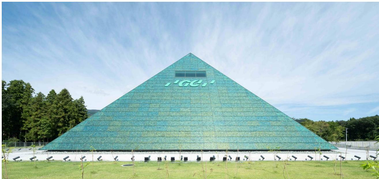
建設中の新東名高速道路に隣接する敷地に、会社創立100年を記念したシンボリックな工場の設計を依頼された。高速道路の車からも目立ち、歯科材料の原料である高純度のガラスを製造する工場らしく、更にトップには関係者が集う富士山の展望スペースを設けることが要求された。ガラスの製造工程により下階の面積は大きく、展望スペースは小さく、また富士山とのコントラストとなるようにピラミッド形が導き出された。工場で使われる電力を最大限補う発電をするため、ピラミッド状であれば日射量の少ない北面も発電できることを確認し、全面をソーラーパネルで覆うこととした。
