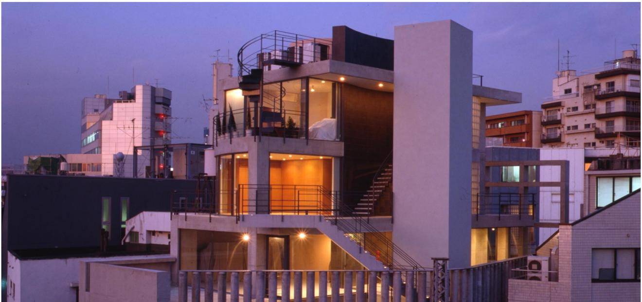
RC造による店舗、事務所、住宅のコンプレックスである。敷地は変形5角形であり、その最長辺である北側隣地境界に沿って長方形の居室を配置し、道路側と線路側にそれぞれ性格の異なる余白を作り出している。特に線路側境界にあっては杭用PCパイプ55本が境界に沿って並び、このコンプレックスを性格づけるセミパブリックな吹抜空間を内包している。
