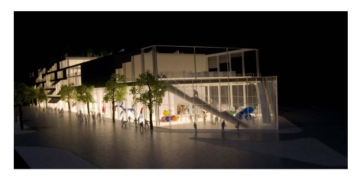
プロード美術財団ミュージアムの設計。3層のファサードによって、様々な展示スペースを作り出す。メタルシャッターの開け閉めによって、自然光の入り具合を調整できる。また、シャッターを外にスイングさせることで日よけにもなる。 ガラスシャッターを開くことで、外部との視覚的および物理的な接続を可能にする。
