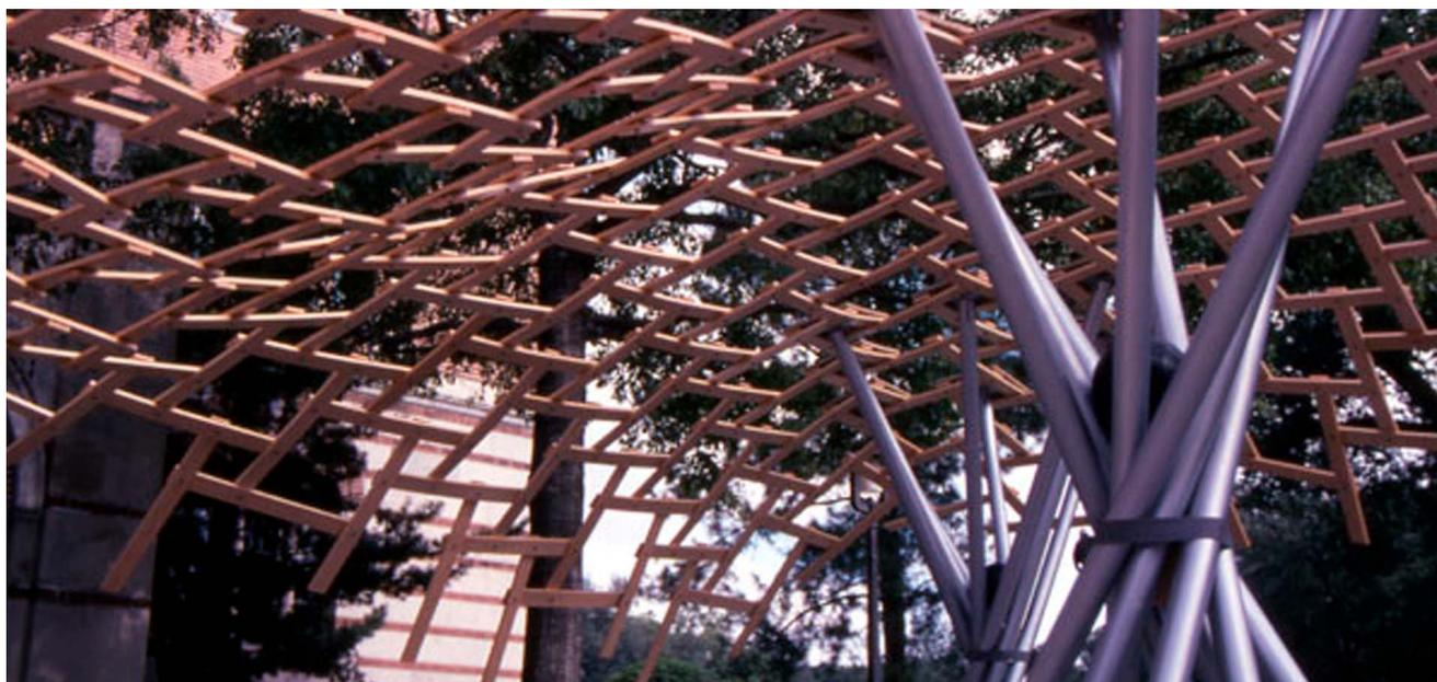
スパイラル状に重ね合せ、ピンで留めた4枚の竹のボードを1ユニットとするこのキャノピーは大小の正方形パターンをもち、凸面と凹面をもつグリッドシェルとなる。このキャノピーは、セントルイスのフォレスト・パーク・パビリオンの2分の1のプロトタイプである。
