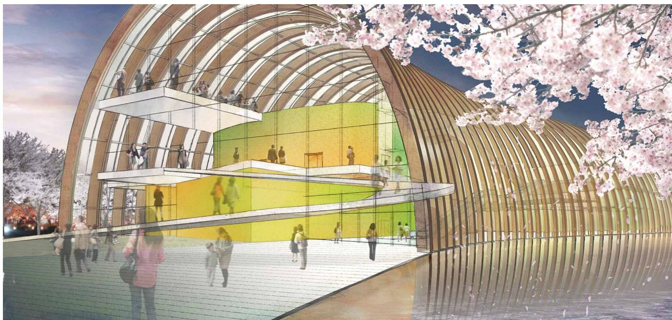
小田原提灯をヒントにした、木のアーチが連続した空間の中に大小のホールを配置している。レストランをホール上に計画し、木のアーチでお城の景色を額縁のように切り取り、芸術施設と歴史的情景を一体化する。トンネルアーチの構造は、鉄骨プレートのアーチを小田原産の集成材でサンドウィッチし、集成材は鉄骨の耐火被覆と座屈抑えとして機能する。鍵型の変形敷地と複数の異なる形態の施設をバランスよくまとめるため、提灯の蛇腹の構造をヒントにして、敷地形状に馴染むトンネル状の半円筒の建物とした。
