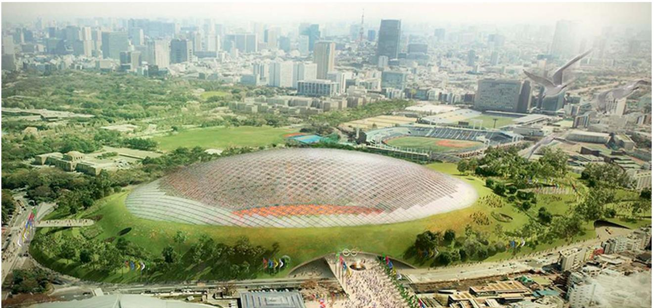
周囲の緑の延長として、違和感なく環境にとけ込むスポーツの丘。日常的に公園として、公開空地として、人々の憩いの場となる立体公園を計画した。立体公園に配置されたスタジアム屋根は断面の小さな軽い構造（グリッドシェル）とし、競技場全体を覆っている。また小さいグリッド（5 m x 5 m）のそれぞれの中を開閉する小さなスクリーンで構成される自在な開閉屋根とした。これにより、従来の開閉屋根を持つ競技場に比べ、鉄骨量を約1 / 3削減でき、世界最軽量の開閉式屋根となる。
