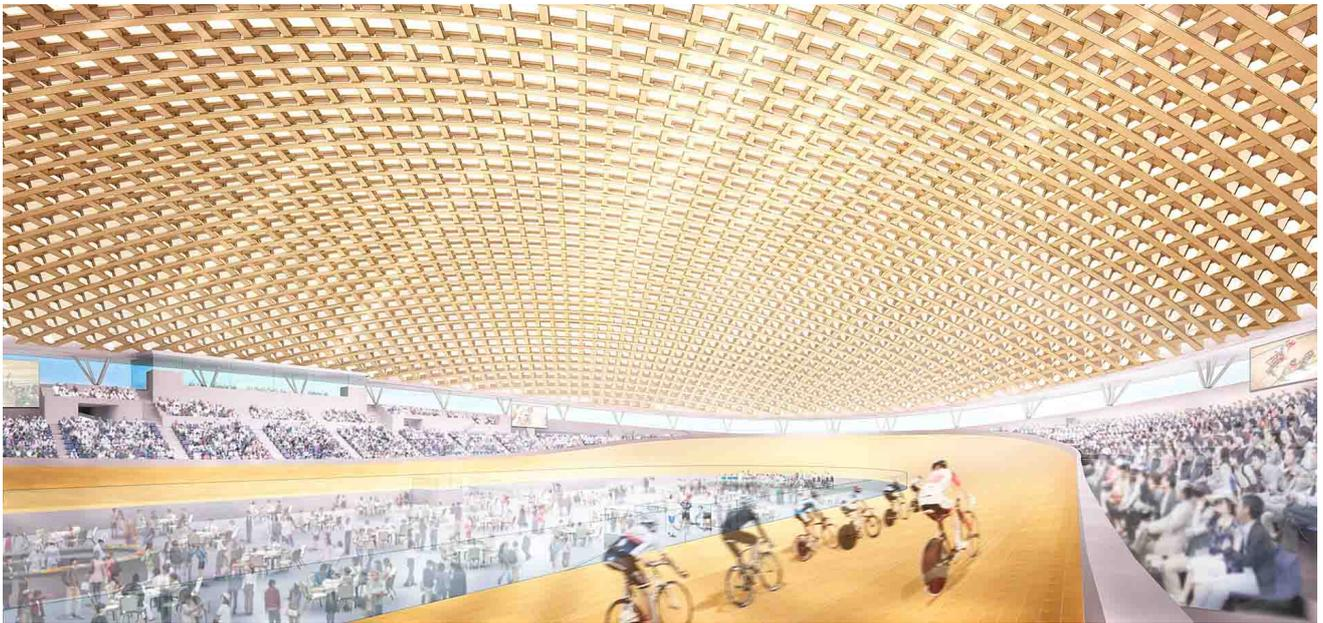
千葉公園内に建つ老朽化した競輪場を屋内型自転車競技場に建て替える計画。RC躯体からV字柱で持ち上げられた木造ドームは、球体の一部を長辺120m×短辺105mの楕円形で切り取った形状で、上下弦材と束材からなるフィレンディールアーチの集合で構成されている。上弦材と下弦材の曲率を変える事で梁成をドーム頂部から脚部に向けて徐々に大きくした構造的合理性のある架構である。
