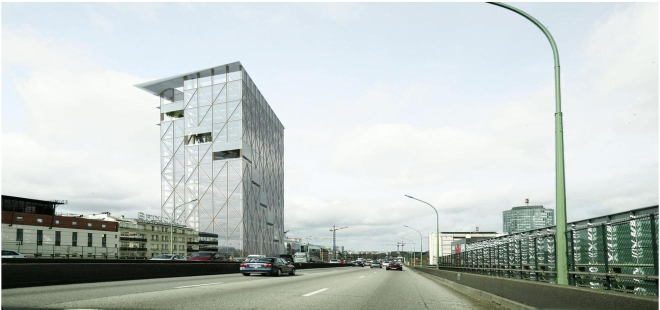
パリを取り囲む環状線沿いに建設が予定された、高層オフィスビル計画。ファサードに木のトラス構造を採用することで、柱のない内部スペースと柔軟性の高いフロアレイアウトを可能にした。また、陽光を受けると透明度が増す特殊な処理をファサードガラスに施すことで、オフィス全体の透明性の高さを表現し、周囲の環境に美しく調和するデザインを考案した。
