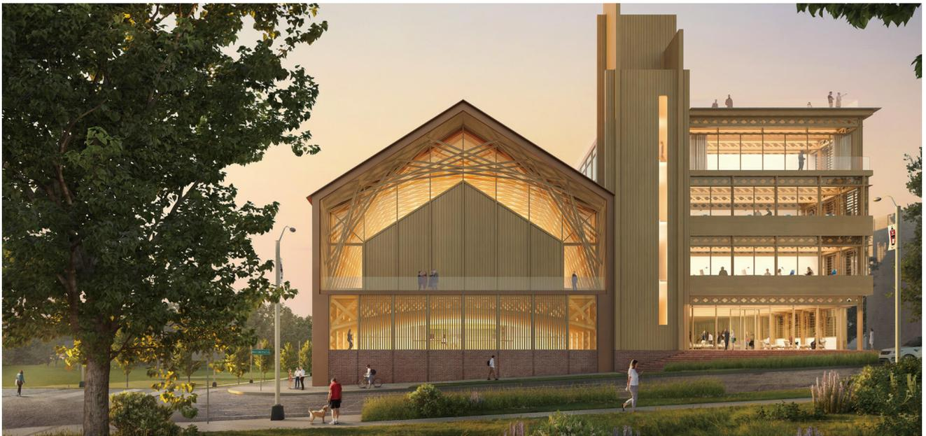
都市の一等地に位置するイノベーションセンター。シンプルでクラシックな建物形態は、工房、時計塔、教室棟など、建物のプログラム化された用途を反映している。革新的木造システムの集大成となる設計であり、学術施設として定められたニーズを特に満たすものとなる。例えばワイドスパントラス、小径の柱、グリッドシェルドーム、立体骨組スラット、CLT壁スラブ、ダボ積層デッキなどが用いられる。各構造システムは空間の機能的必要性を満たしつつ、日当たりや開放性、柔軟性、相互連携といった研究学習に最適な環境を育み、交流を促進する。このプロジェクトでは地元生産、地元製造材料を特に活用しており、州が育成する木材産業を後押ししている。
