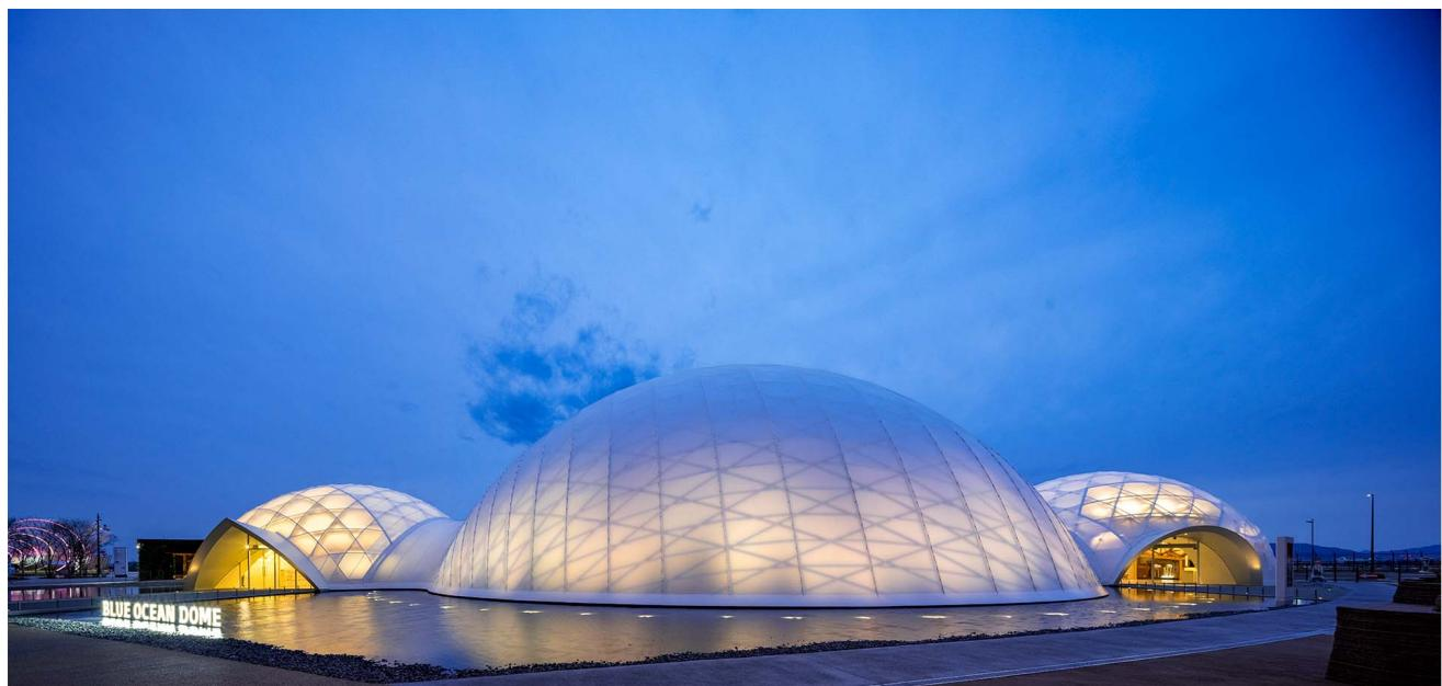
2025年大阪 関西万博におけるパビリオンで、豊かな海を次世代へ残すための啓発を目的としている。竹、CFRP（炭素繊維強化プラスチック）、紙管という異なる素材を用いた大小3つのドームが一体となり、三次曲面の形状を構成している。ドームAは、曲げ加工した竹集成材による直径19mのドームである。竹は成長が早く3~4年で伐採できる一方、放置竹林による竹害が問題となっている。その解決策として、高知県産の竹を小幅材に分割し、蒸気処理を経て接着剤を塗布・圧縮して面材化。厚さ8mmの面材を曲げながら6層重ね、厚さ48mmとした材で、伝統的な竹細工に見られるような幾何学のドームを構成した。
