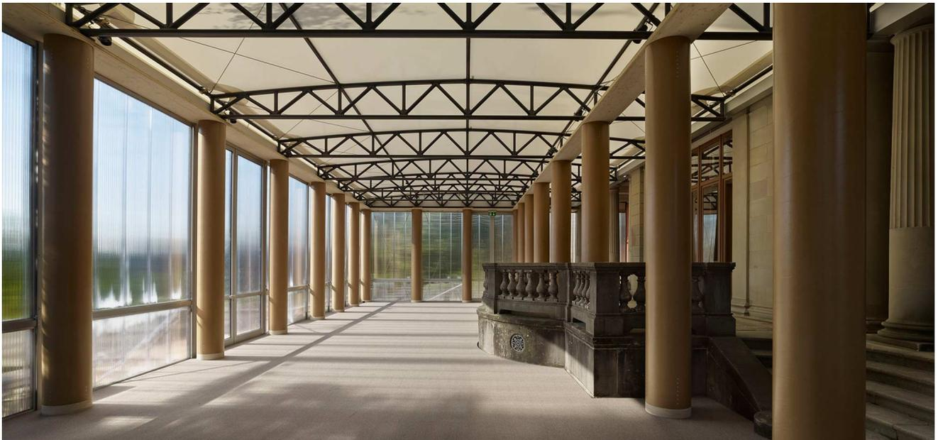
パビリオンの主幹構造は、紙管の柱、屋根を支える超軽量のカーボンファイバートラスで構成されている。パビリオンの使用は毎年夏の3ヶ月のみで、それ以外の時期は倉庫に格納される。紙管を大小2種の径とし入れ子状に格納可能とすることで、収納時の省スペース化も実現した。大型の重機なしに組み立てられるよう、カーボンファイバートラス、膜屋根およびポリカーボネートの外壁を用いた。
