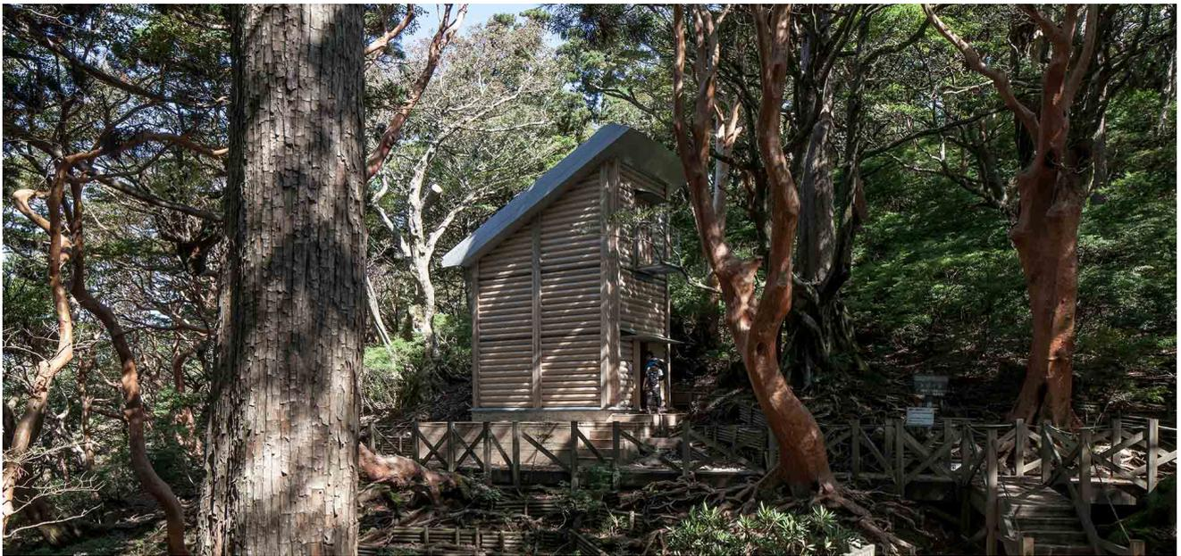
鹿児島県屋久島町、国立公園内の標高1300mにある避難小屋。老朽化した旧小屋の基礎を利用し、鉄骨3階建ての計画とした。壁面の紙管と紙管の間には隙間を設けて透明チューブを詰め、電気もない内部にも光が入るようにした。紙管は補修が必要な時に一本一本簡単に交換ができるようにした。
