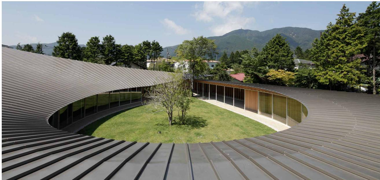
旗竿敷地に建つ木造 2 階建ての住宅。敷地に対し、30m角の正方形の建物に直径15mの中庭を配置。その中庭を中心に居室が配され、玄関から居室が放射状に配置しているのが見える。リビングは8枚引き戸を開け放つことにより、内外部が一体となり、中庭とリビングが一体として使える。柱と梁は75 x 350のL字に組まれており、L字が放射状に配置され、大きな1枚の片流れ屋根を構成している。この一枚の大きな屋根は天井高さが2.4m～7.45mまで変化する。
