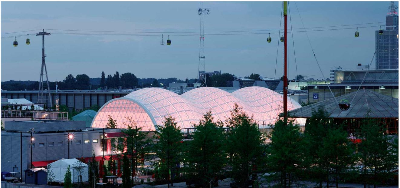
ドイツ、ハノーバーで開かれた、サステナビリティをテーマとしたEXPOにおける紙管のトンネルアーチ。リサイクル可能な紙管でできた3次曲面のグリッドシェルであり、それぞれの紙管を布のテープで接合し、はしご状の木造アーチにより補強し、耐火性の紙の膜により全体を覆っている。
