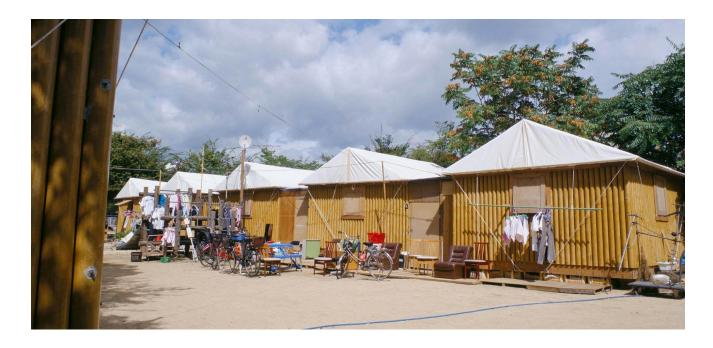
阪神大震災の被災者のためにつくられた仮設の紙のログハウス。安価で誰でも簡単に組み立てられ、夏冬の断熱性能を有するよう設計が進められた。基礎には砂袋入りのビールケース、壁と小屋組は紙管、天井と屋根にテント膜を使用している。コストを抑えるとともに、解体しやすさ、残材の処分、サイクルコストの面でも優れたものとなっている。
